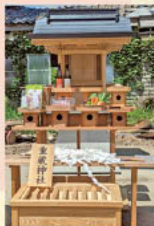
完成した社殿
