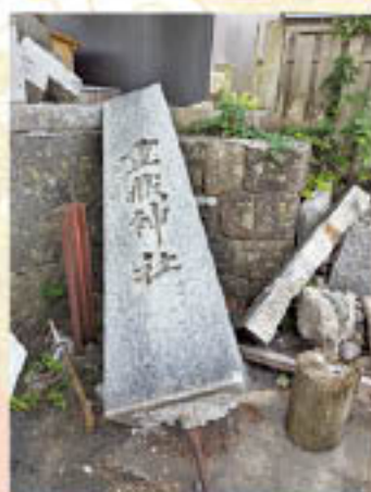
倒壊した石柱
