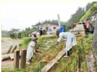
午後の作業を行った諏訪神社。立ち入れない程草が生い茂り、本殿は震災で倒壊したままであった。
